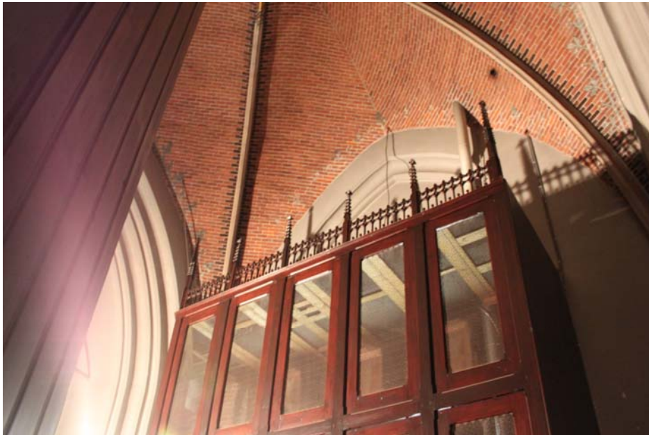
Bovenzijde hoofdwerkkas (foto Kees Doornhein)
